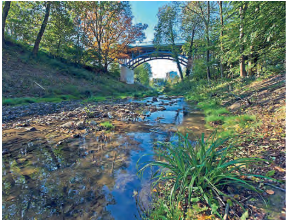
...auch an Begleitmaßnahmen zum Emscherumbau beteiligt.
