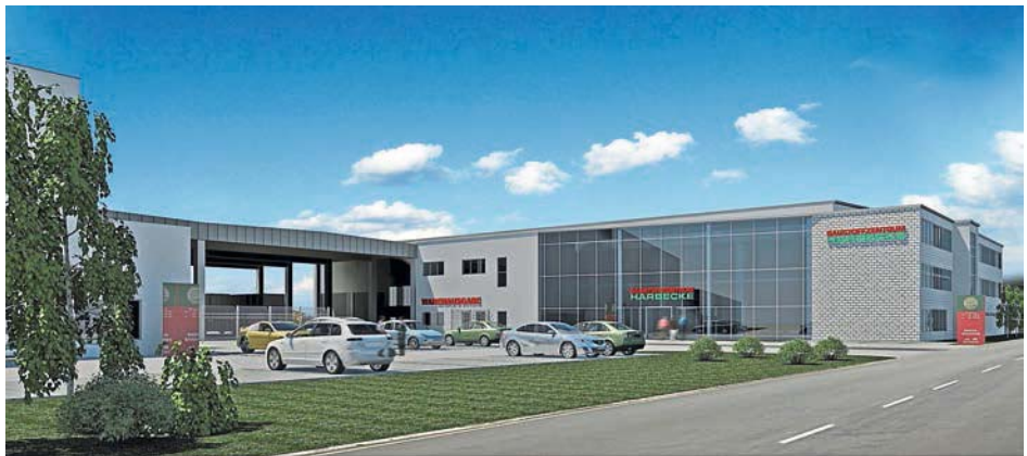
Kürzlich eröffnete das Baustoffzentrum Harbecke am neuen Standort.
