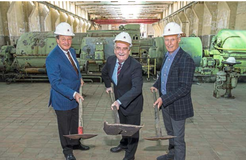
Mitte Juni gaben NRW-Bauminister Michael Groschek (Mitte), Claus Dürscheidt (rechts), Sprecher der Investorengruppe Convention Hall Zollverein GbR und Hermann Marth, Vorstandsvorsitzender der Stiftung Zollverein, mit einem symbolischen Spatenstich den Startschuss für den Ausbau der ehemaligen Sauger- und Kompressorenhalle. Foto: Jochen Tack/Stiftung Zollverein
