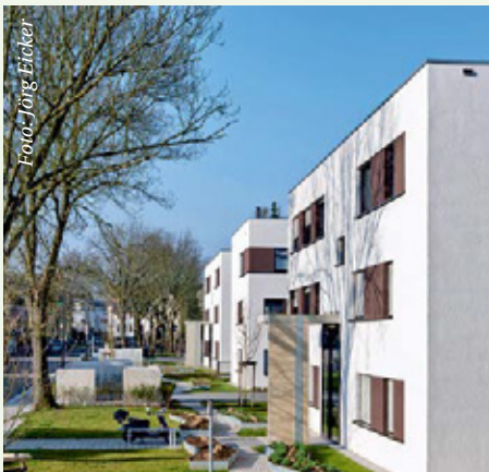
„Quartier der Generationen“, Essen
