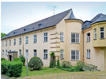
Tilsiter Straße, Mülheim an der Ruhr
