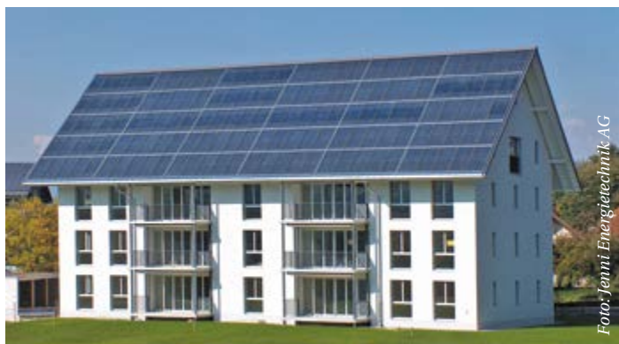
Baujahr 2007: Mehrfamilienhaus in der Schweiz von Jenni Energietechnik mit acht Wohneinheiten und einem Primärenergiebedarf von 4 kWh/m 2 a. Es beheizt sich mittels Solarthermie und Langzeitwärmespeicherung ganzjährig zu 100 Prozent nur mit der Sonne. Auf eine Heizkostenabrechnung wird verzichtet. Es gibt Wartelisten für die Vermietung.
