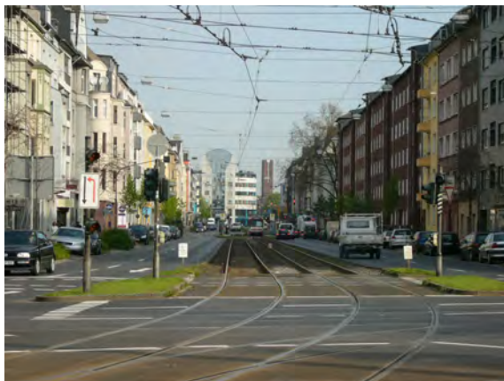
Ansicht Richtung Lindenstraße
