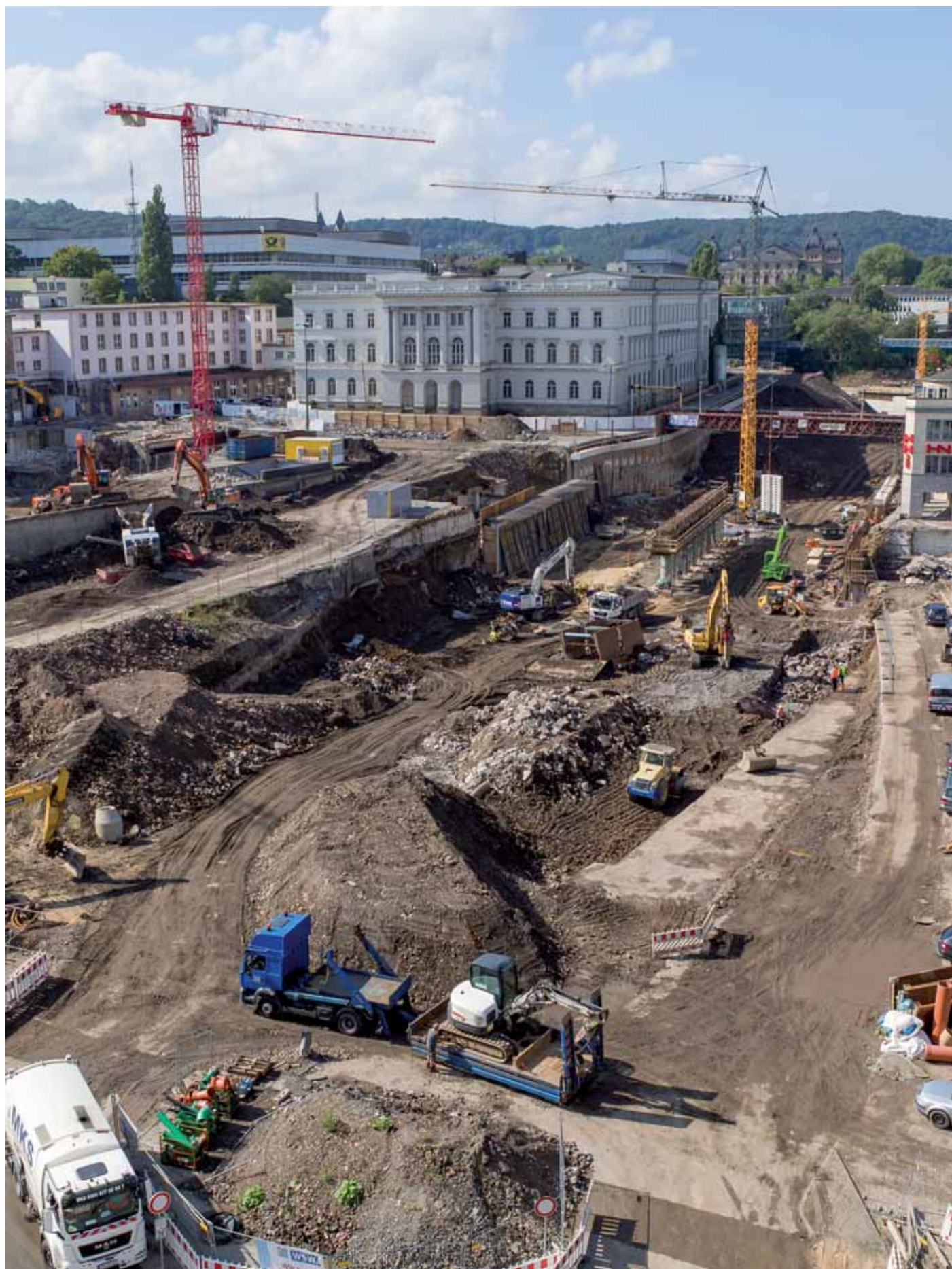
Umbauarbeiten am neuen Döppersberg.
