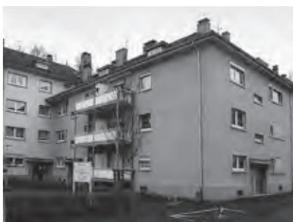
Vor der Sanierung / before renovation
