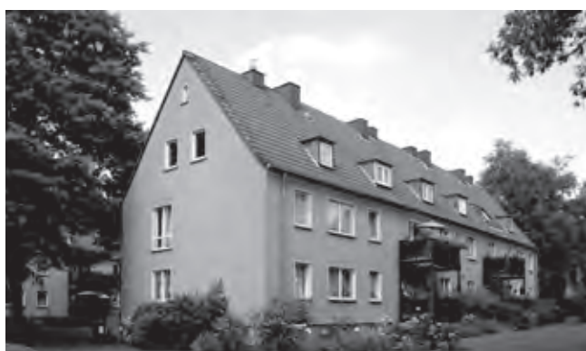
Vor der Sanierung / before renovation
