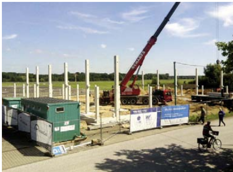
Der Baufortschritt am Hugo Junkers Hangar ist sichtbar.
