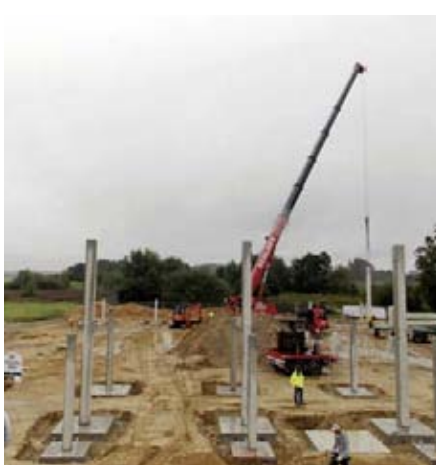
Der Rohbau am Flughafen hat begonnen.
