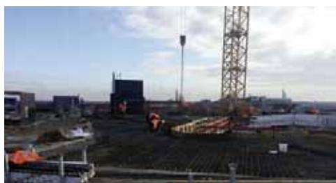
**Die Arbeiten für die Stahlbetondecke über dem 1. Obergeschoss.** Auf dieser Betondecke werden bald Autos parken.
