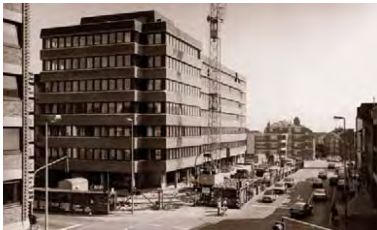
Das Gebäude kurz vor der Fertigstellung.
