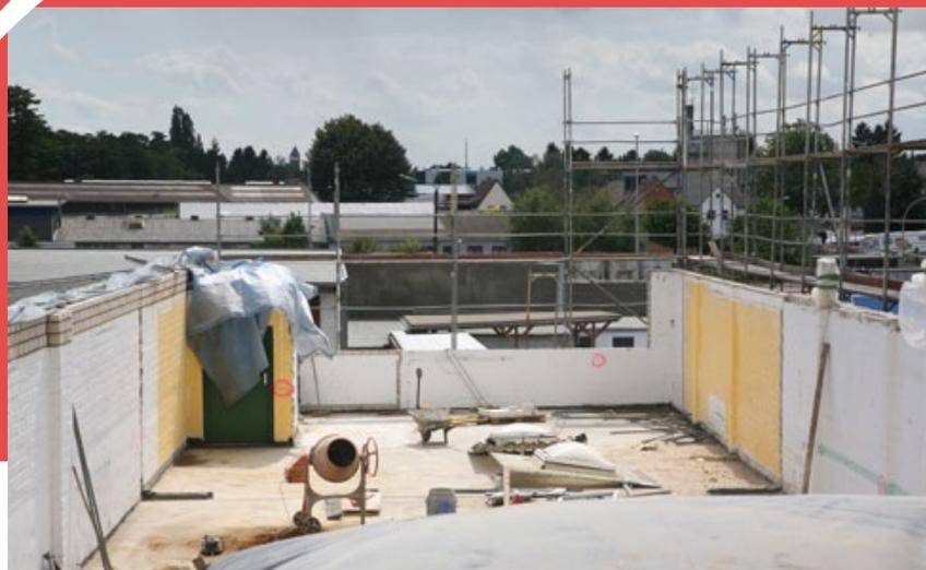
Sommer 2014: Der Dachstuhl ist demontiert, die Außenwände werden ertüchtigt.
