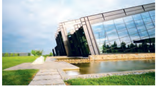
Headquarters of AMADA GmbH in Haan Der Firmensitz der AMADA GmbH in Haan
