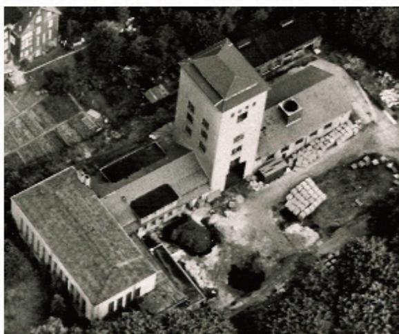
Abb.16: Pörtingsiepen Schacht III (Materialförderung, Abwetterschacht) aus der Luft. Zum Aufnahmezeitpunkt ist der Schacht schon außer Betrieb gesetzt. Foto: Slg. Richard Voigt
