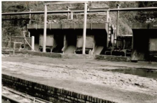
Abb.4: Die Waggonentladung des Bergeschachtes (gebaut 1943/44) Hesperbrück in den sechziger Jahren. Foto: Slg. Richard Voigt
