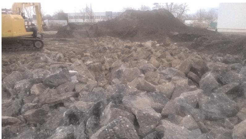
Entfernung von Betonfundamenten an der Bamler Str.
