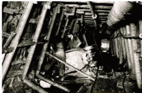
Abb.10: Verfüllung ausgekohlter Bereiche. Das umkippen der Bergewagen war schwer und so wurden die Gleise leicht schief verlegt. Ab und zu ging auch mal ein Wagen verloren und fiel mit in den zu verfüllenden Bereich. Natürlich gab das Ärger vom Steiger und so wurde der verlorene Wagen mit Haufwerk abgedeckt denn eine Bergung war so gut wie nicht möglich. Foto: Slg. Richard Voigt
