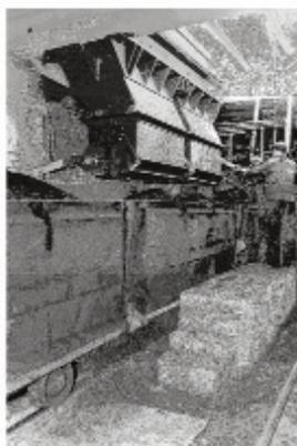
Abb.12: Bergeladestelle - Brechanlage auf der fünften Sohle der Zeche Carl Funke. Foto: Slg. Richard Voigt
