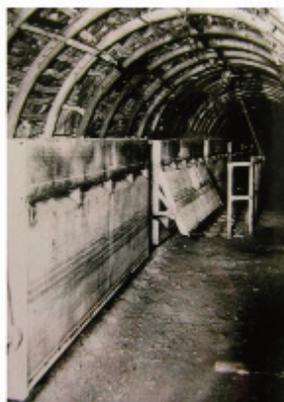
Abb.13: Pörtingsiepen Schacht III, Ort 5, autom. Bergeladestelle für den Bergebunker SW 611 mit speziellen Bergewagen. Foto: Slg. Richard Voigt
