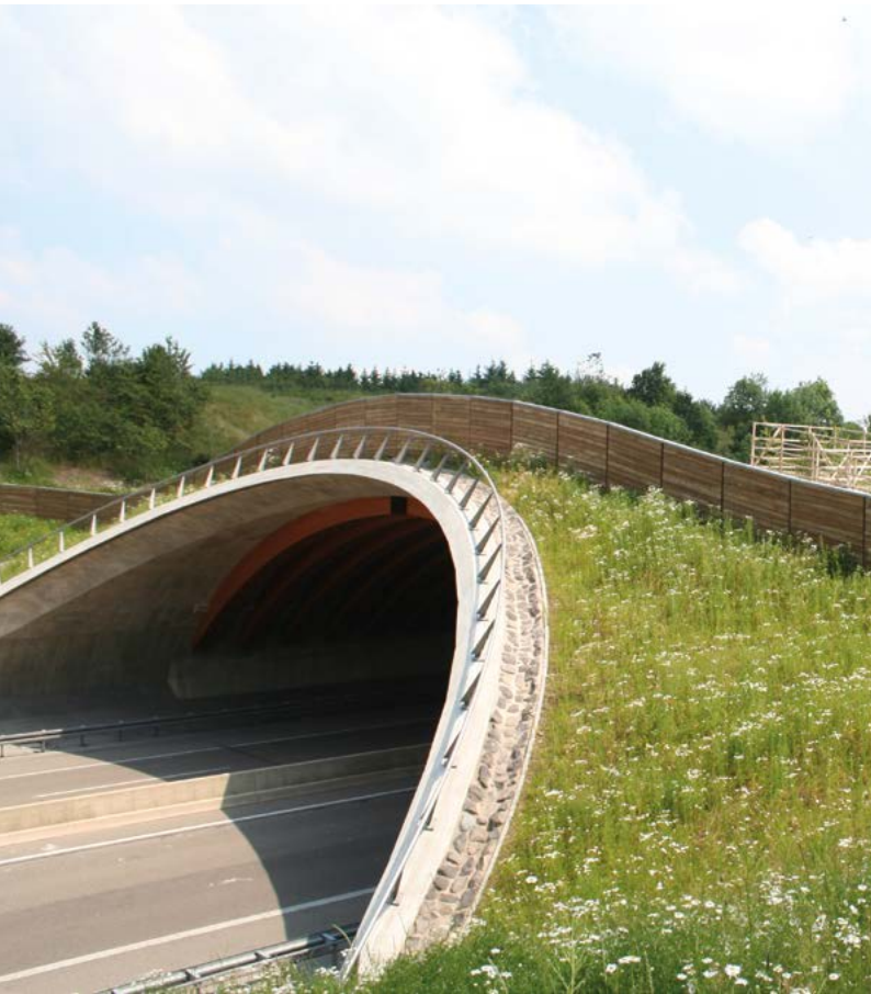
Wildbrücke über die A1
