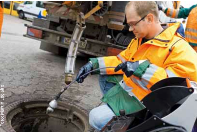
Carsten Jelinek bei der Kanalinspektion mit der Spezialkamera
