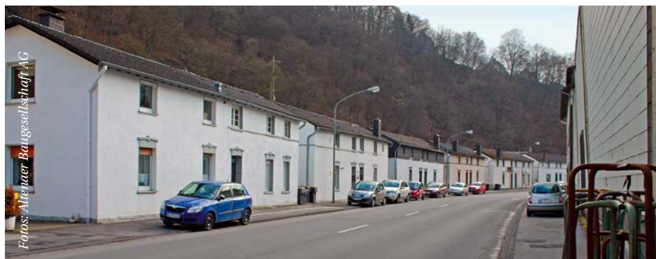
Hier fing alles an: Arbeiterhäuser an der Werdohler Straße.
