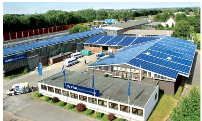
Firmengebäude in Bochum mit eigener Dachanlage
