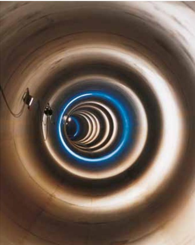
In den Emscher-Umbau investiert die Emschergenossenschaft über einen Zeitraum von fast 30 Jahren knapp 4,5 Milliarden Euro. Ein unterirdischer, rund 51 Kilometer langer Abwasserkanal macht die Renaturierung des Flusses an der Oberfläche möglich.
