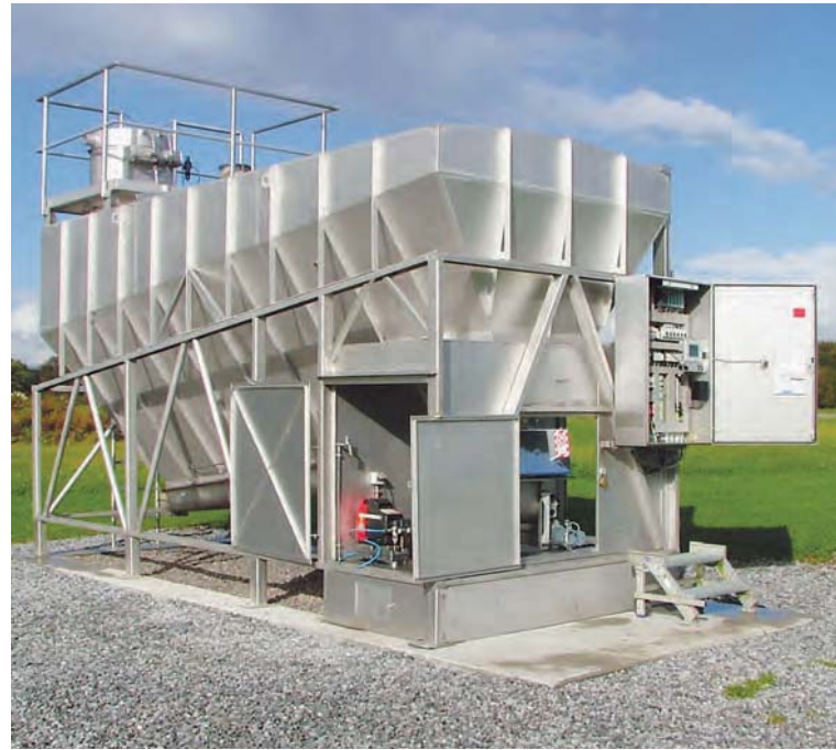
Dosieranlage Pulveraktivkohle
