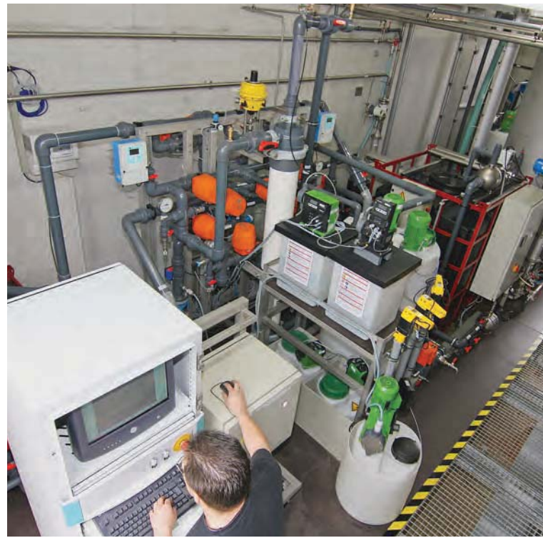
Pilotanlage Echthausen: Druckmembrananlage
