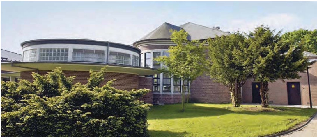
Außenansicht Wasserwerk Essen-Kettwig
