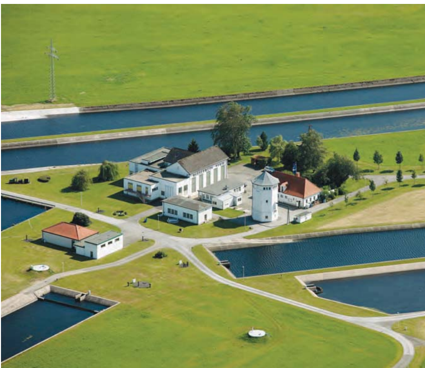
Luftbild Wasserwerk Warmen
