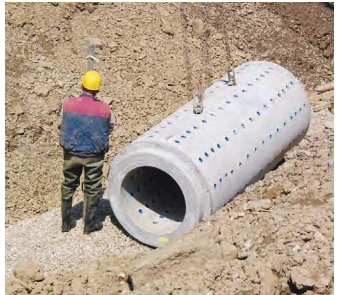
Neubau Sickerleitung Wasserwerk Essen-Horst
