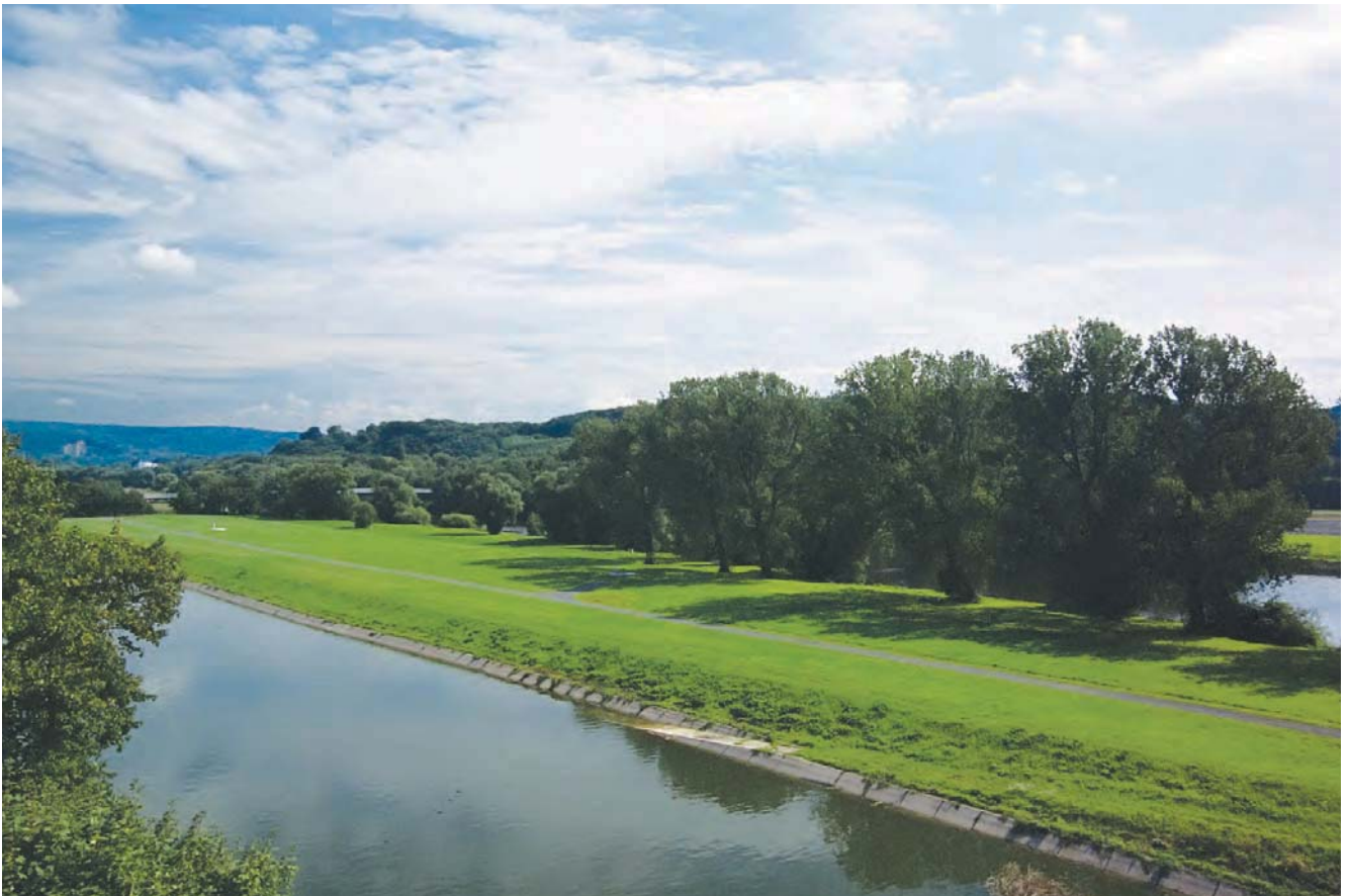
Langsamsandfilterbecken Wassergewinnung Essen-Burgaltendorf)
