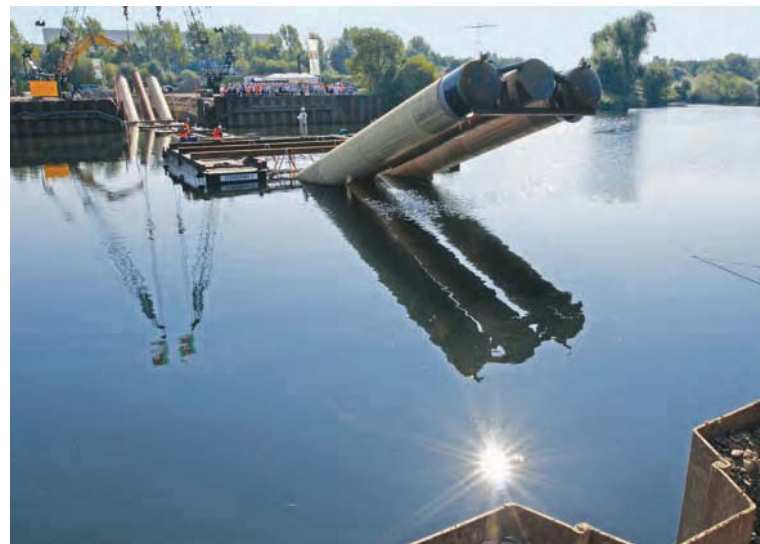
Einschwimmen des Ruhrdücker Verbundwasserwerk Essen-Horst-Überruhr
