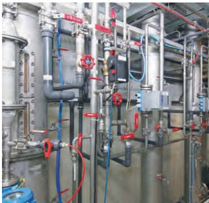
Pilotanlage Echthausen: Edelstahlsäulen mit Mehrschichtfiltern bzw. Aktivkohlefiltern
