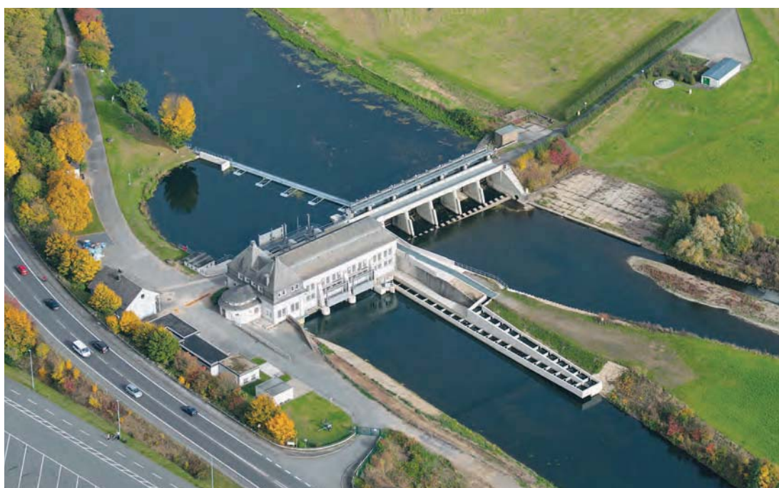
Luftbild Pumpwerk Westhofen 2
