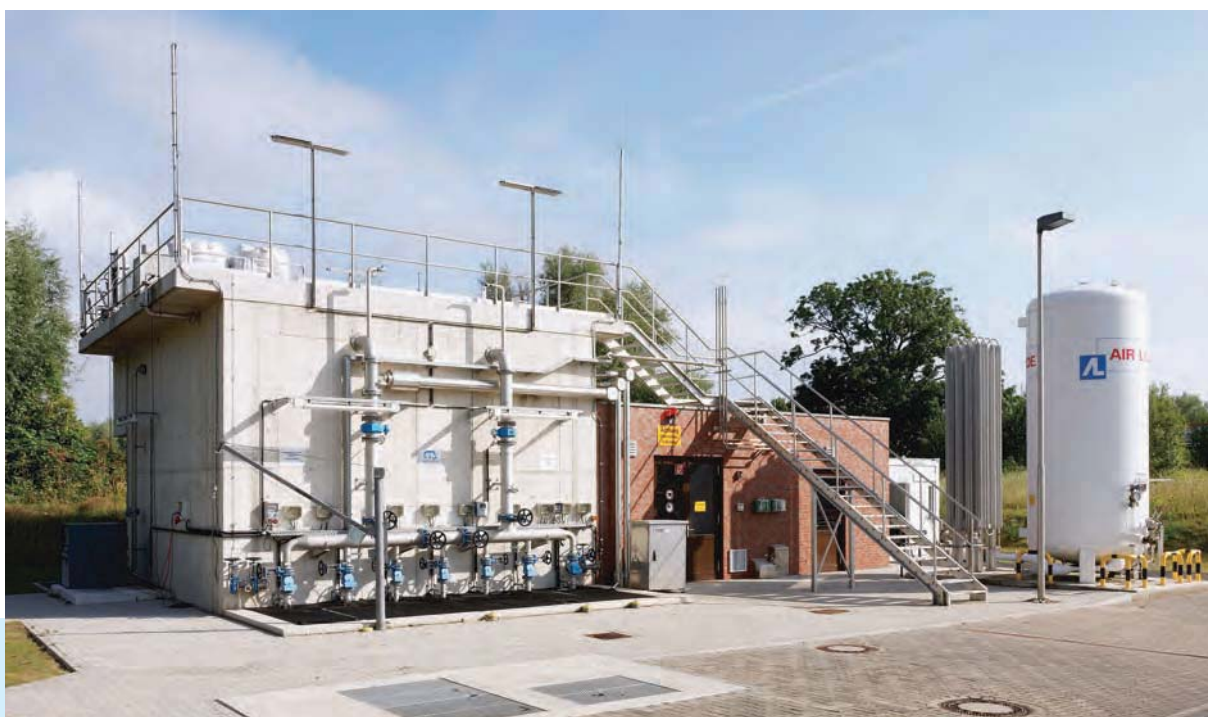
Ozonung Kläranlage Duisburg
