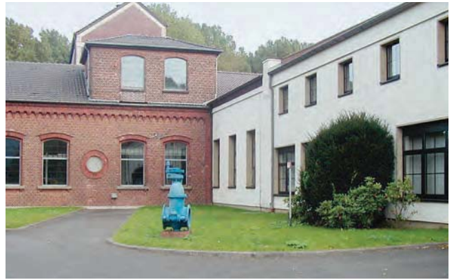
Altes Gebäude und Anbau
