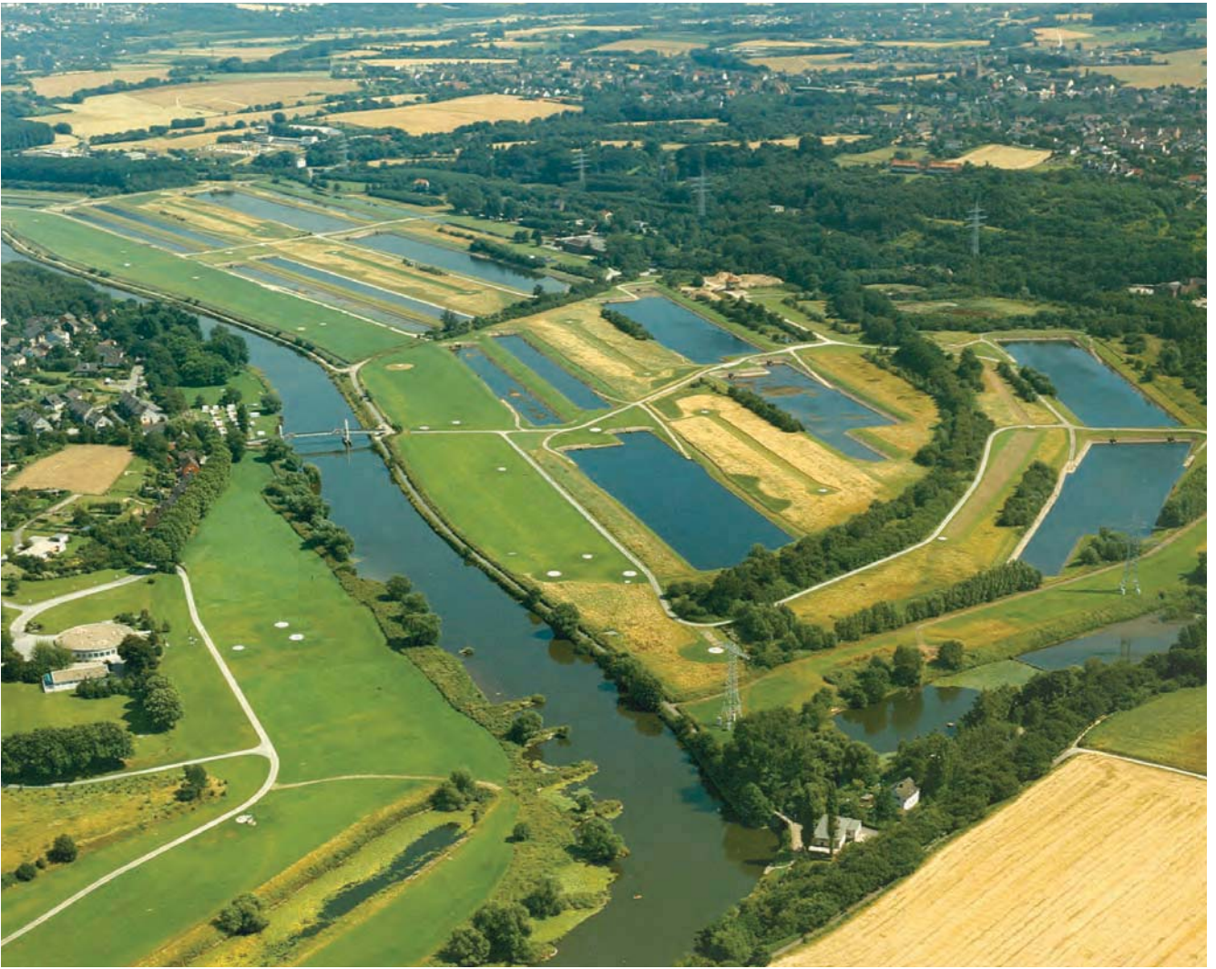
Luftbild Wasserwerk Essen-Horst
