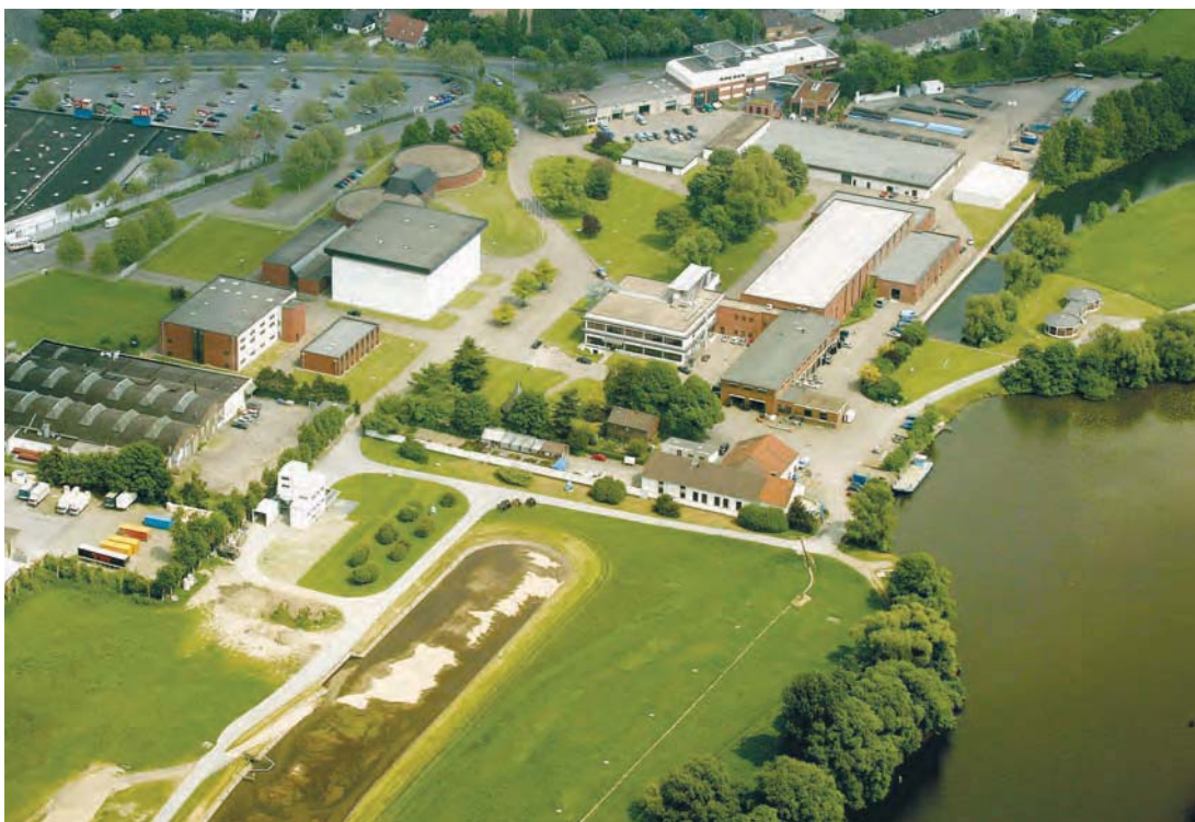
Luftaufnahme Wasserwerk Styrum-Ost
