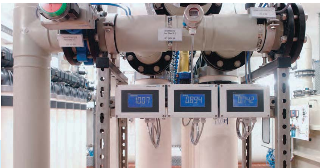
Überwachung der Ultrafiltration
