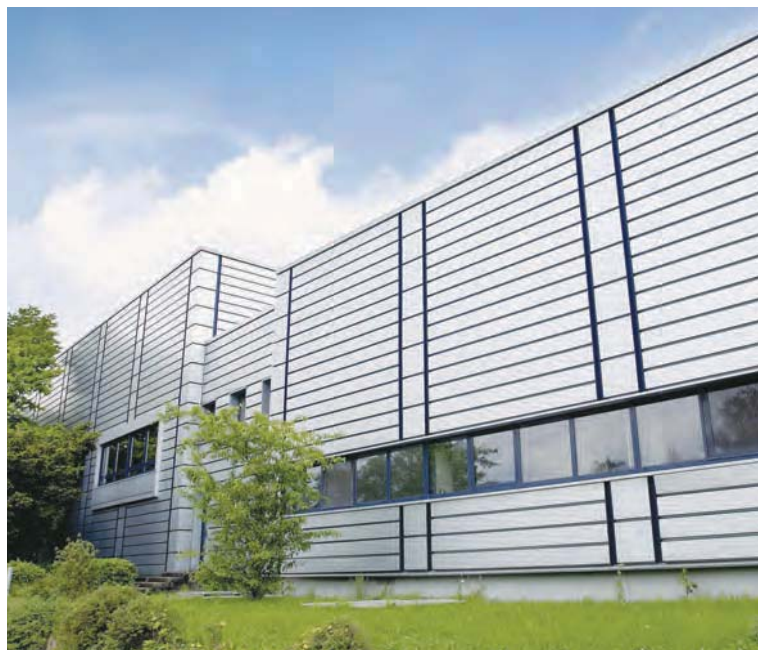
Außenansicht Wasserwerk Mülheim-Dohne
