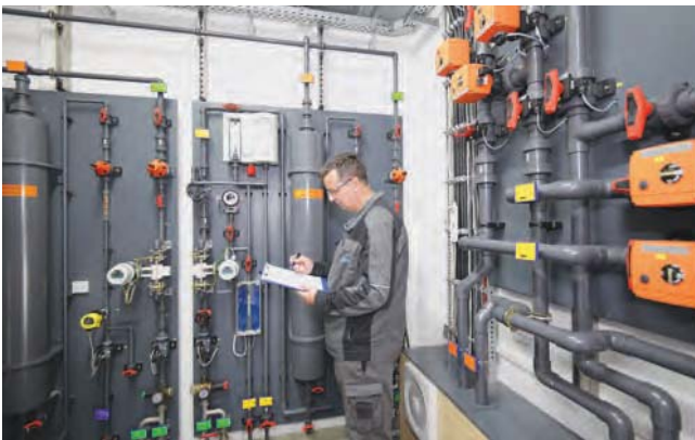
Chlordioxid- Desinfektionsanlage
