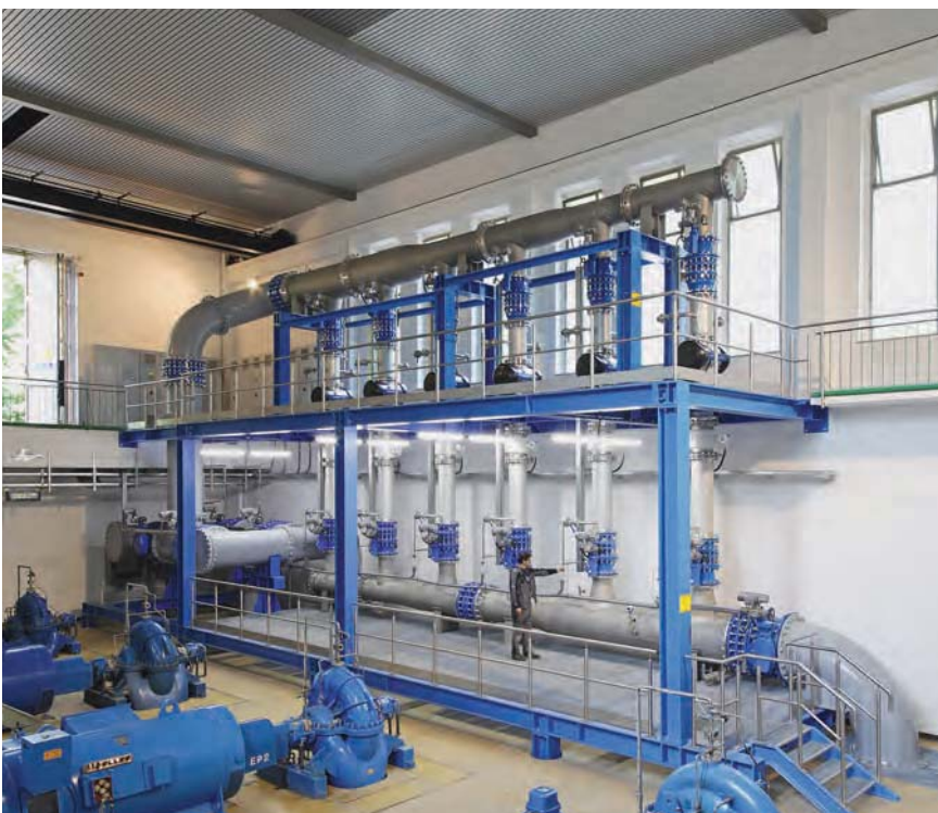
UV-Desinfektions- anlage
