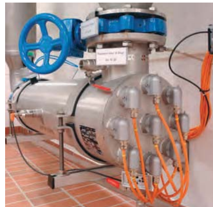
Bild oben: Aktivkohlefilter
