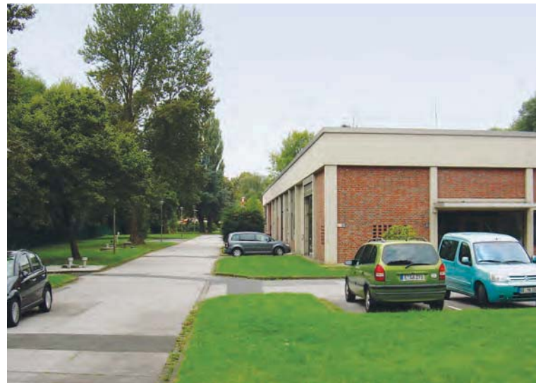
Pumpwerk Wasserwerk Essen-Überruhr
