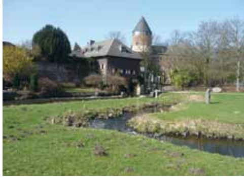
Umgehungsgerinne der Alten Brüggener Mühle an der Schwalm zur Herstellung der Durchgängigkeit.
