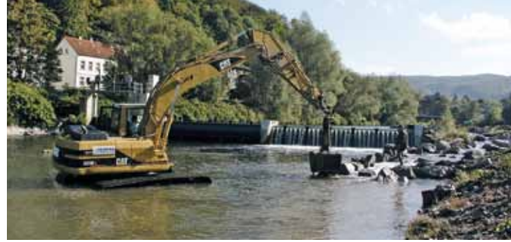
Bau eines Fischaufstiegs an der Lenne.
