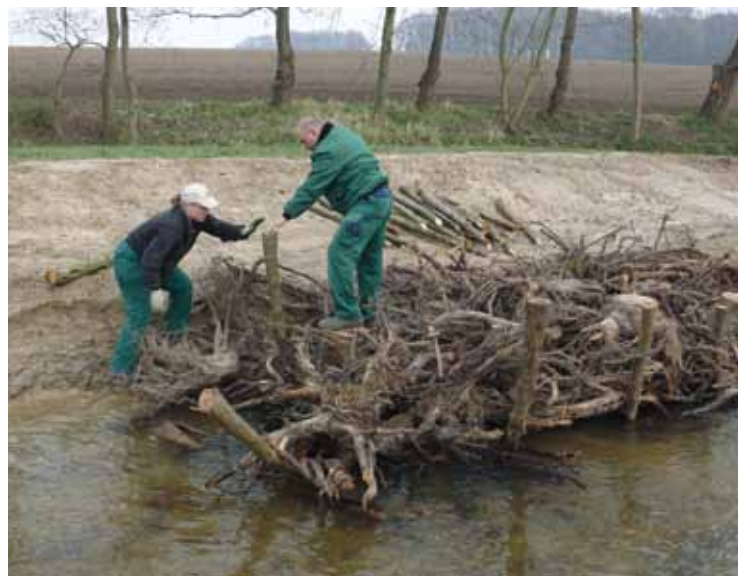
Der Einbau von Strömunglenkern im Uferbereich des Bolldammbaches.
