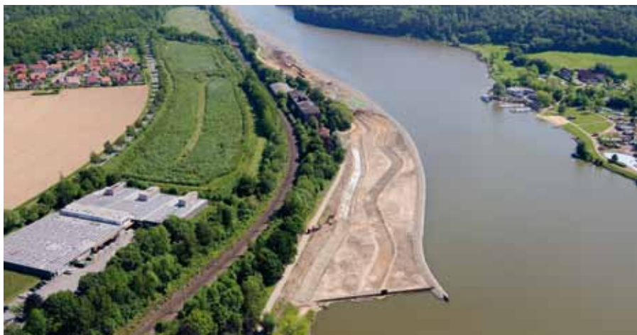
Bau der Schiederseeumflut.
