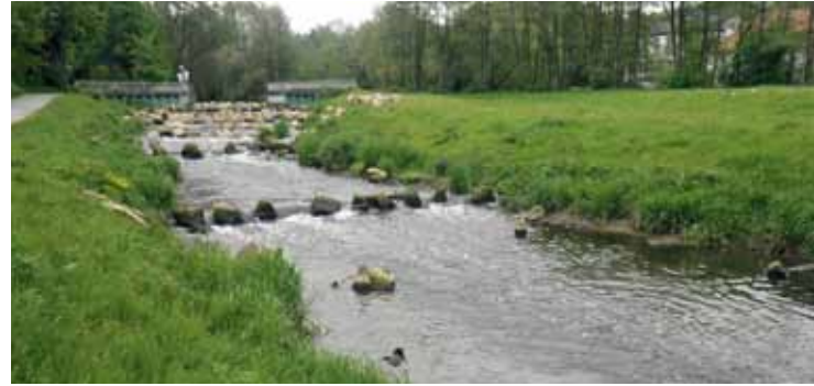
Bocholter Aa – Rückbau der Stauanlage Pröbsting zur rauen Rampe.
