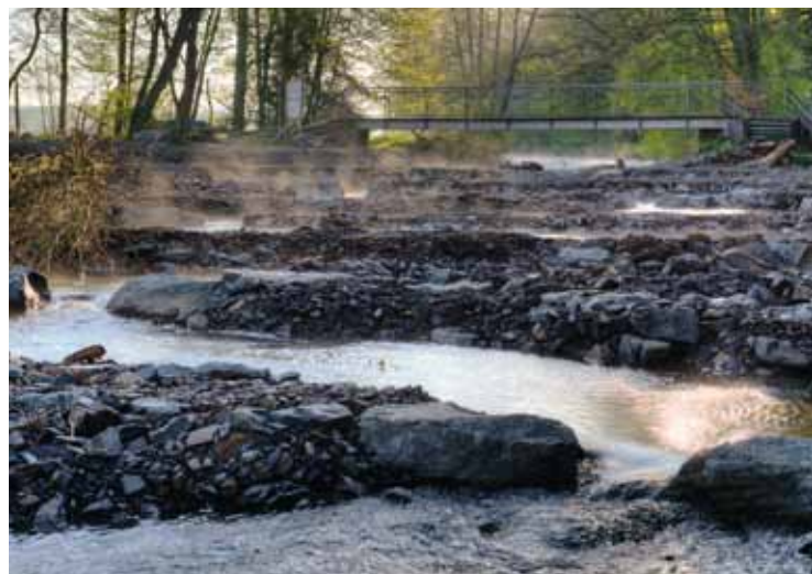
Fischwanderhilfe in Sichtigvor.
