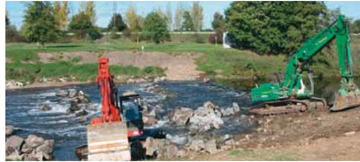
Rückbau eines Wehrs an der Wupper.
