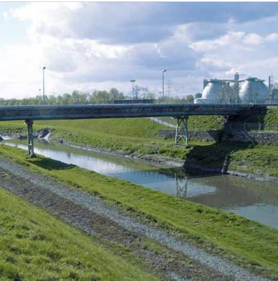
Die ausgebaute Emscher.
