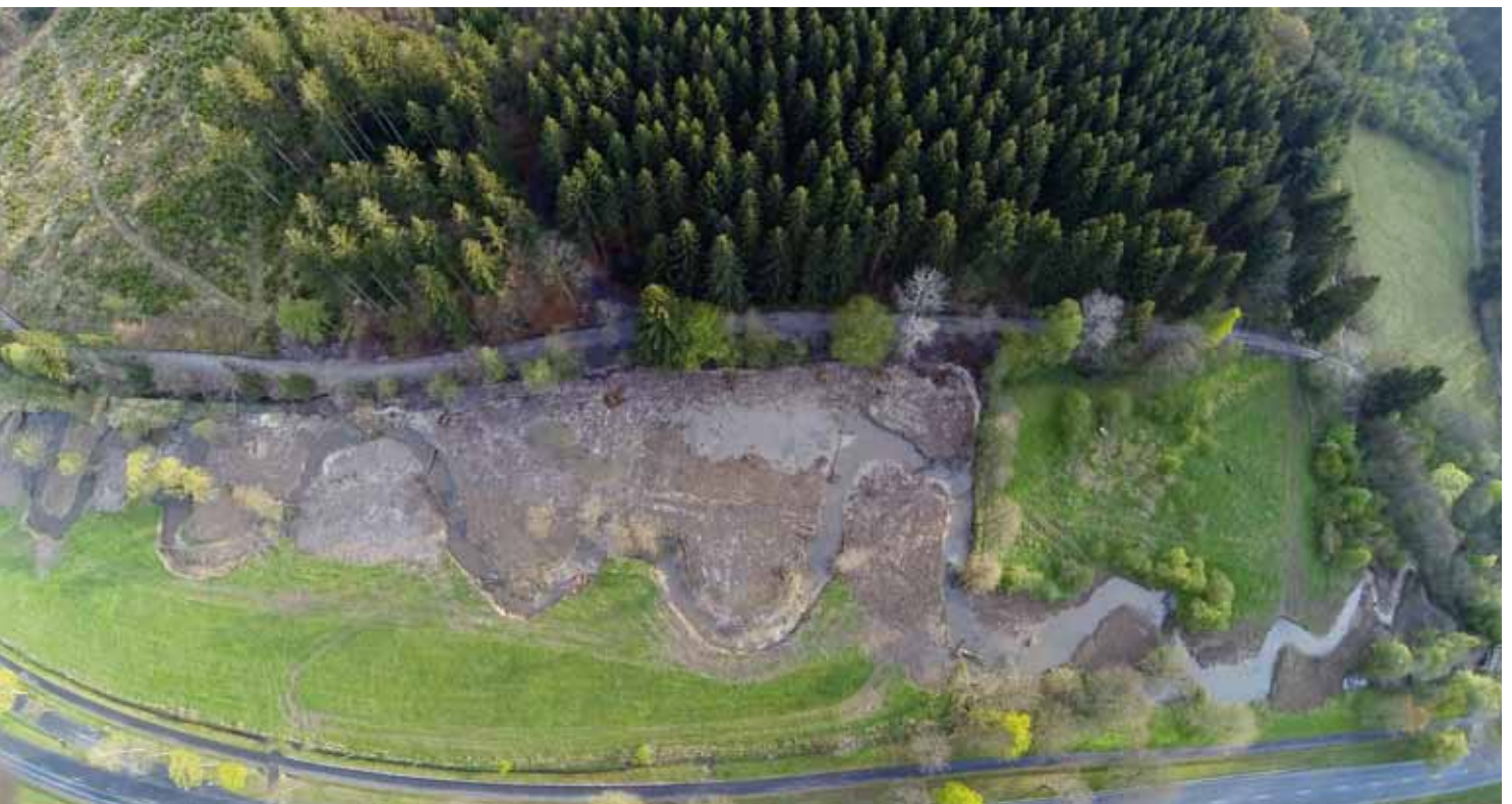
Gewässerrenaturierung am Scharfenberger Bahnhof, zweiter Abschnitt.
