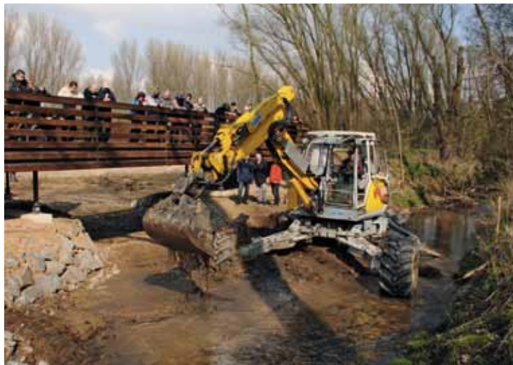
Öffnung des Deiches in Hellerhof und Umleitung des Urdenbacher Altrheins in die Urdenbacher Kämpfe.
