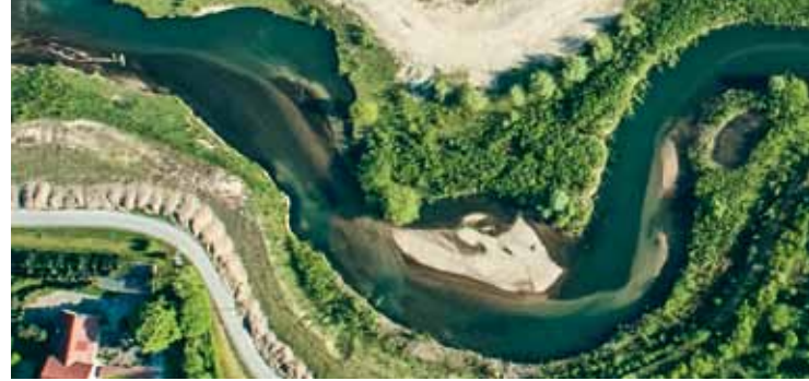
Das neue vielgestaltige Gewässerbett der Lippe.
