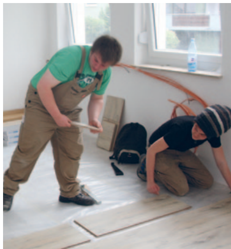
Teil der Ausbildung: Professionelle Bodenverlegung
