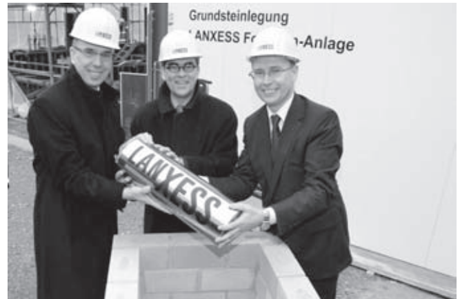
Oberbürgermeister Gregor Kathstede mit Werner Breuers (rechts) und Hubert Fink (links) von Lanxess bei der Grundsteinlegung.
