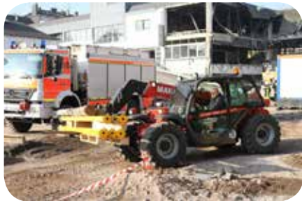
Transport mit dem Teleskoplader.
