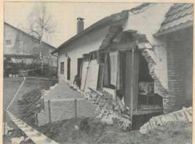
Bei Ausschleusungsarbeiten stürzte am Mittwochabend eine ein- und zweigeschossige Bauwerkzeile an der Einbringer Straße in Wittlar ein. (SP-Foto: Horst Gebel)
