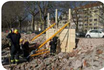
Um ein Nachrutschen zu verhindern, musste eine Stützwand errichtet werden.
