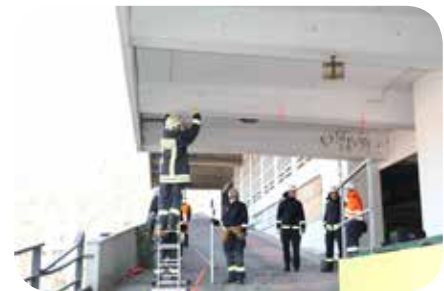
Auf einer Schrägen musste ein Kragarm abgestützt werden.
