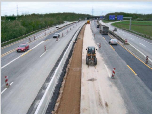
Bild 7: Bau einer frei aufgestellten Betonschutzwand
