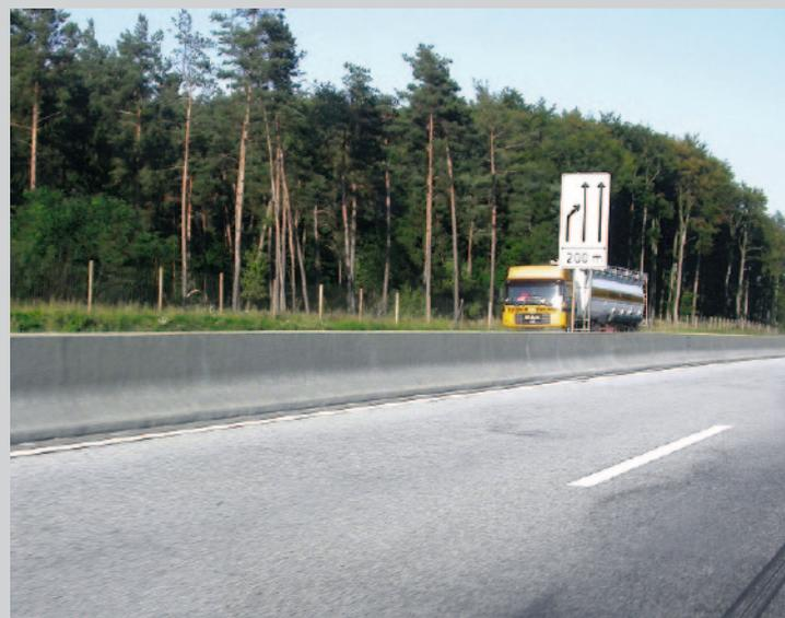
Bild 6: Betonschutzwand mit New-Jersey-Profil
