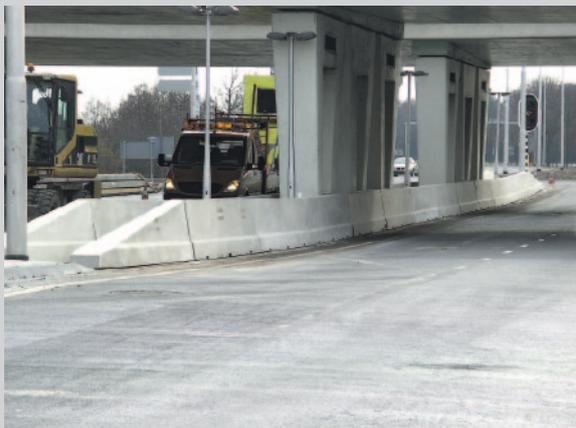
Bild 10: Schutzeinrichtung aus Beton an Brückenpfeilern
