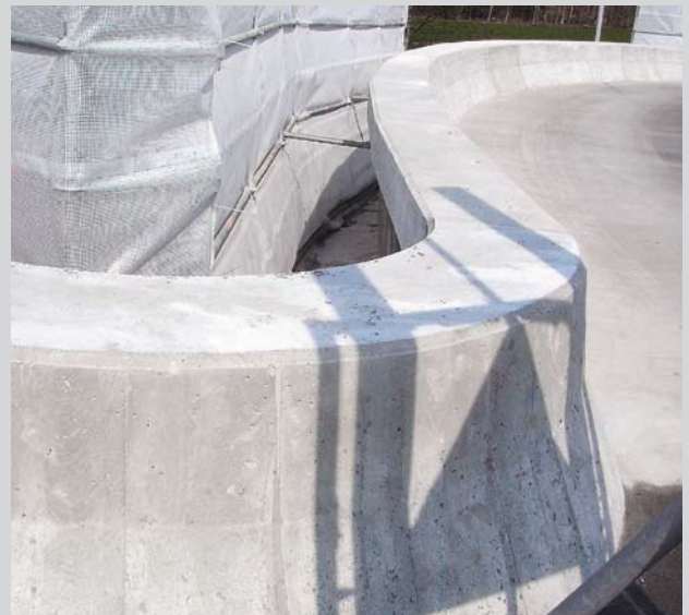
Ansicht an die fertige Brüstung
