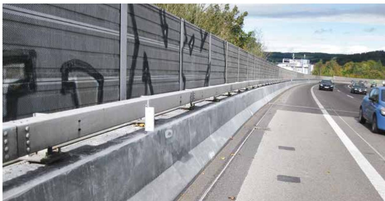
Abb. 5 Fertiggestellte mit UHFB beschichtete Leitmauer
