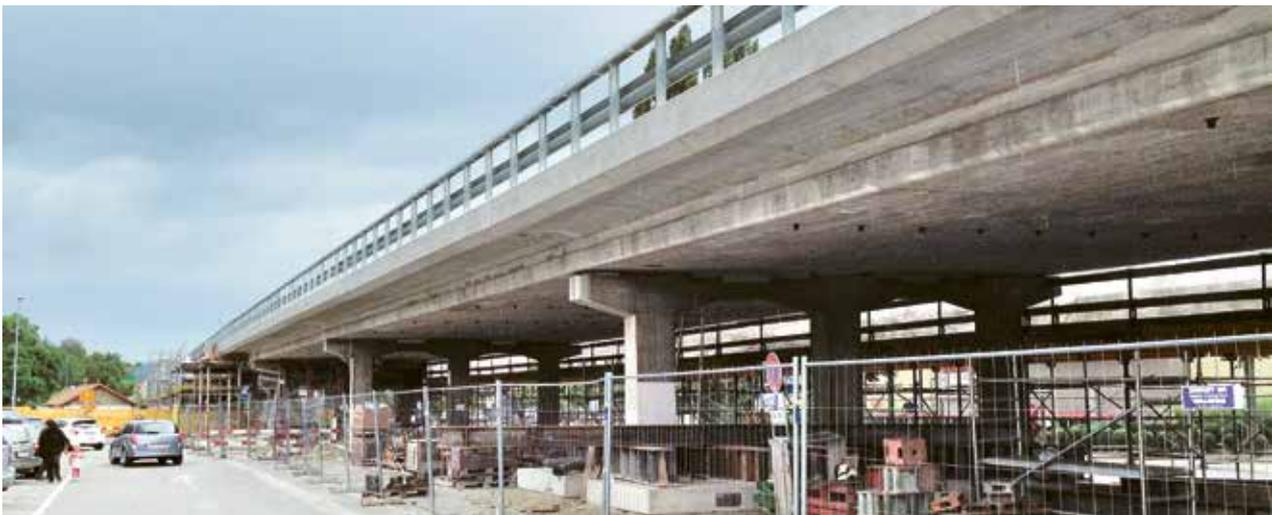
Abb. 11 Untersicht der instandgesetzten Randabschlüsse
