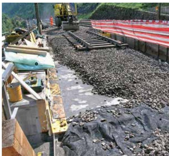
Abb. 3 Einbau Bahnschotter und Gleisrost auf UHFB-Abdichtung; linker Bildrand: Negativschalung für vertikale UHFB-Fläche am Randbord
