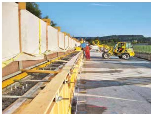
Abb. 4 Vorbereitete Schalung für die Beschichtung
