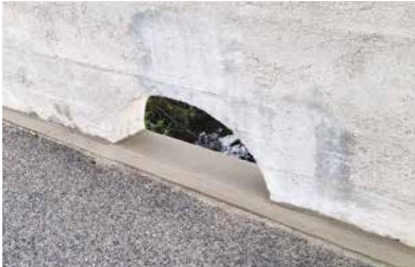
Abb. 6 Detail zur Oberflächenausbildung mit eingestreutem Splitt
