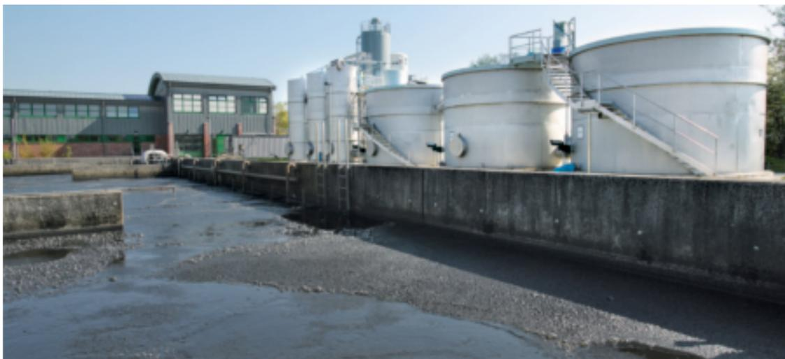
Die Versuchsanlage auf der Kläranlage Schwerte arbeitet mit Ozon und Aktivkohle.
