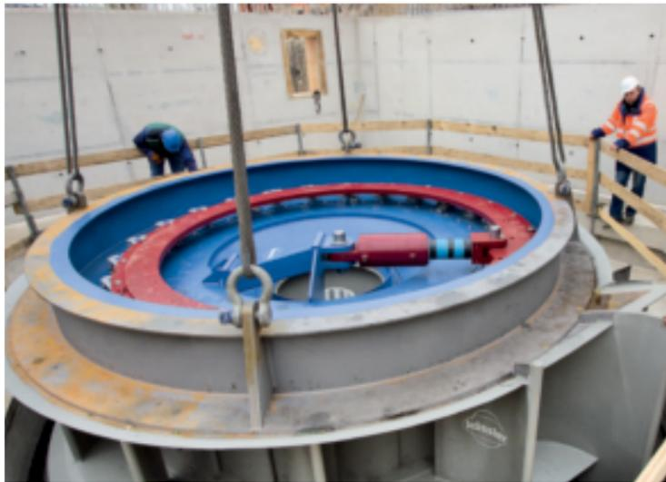
Maßarbeit: Einbau des Turbinengehäuses für das neue Kraftwerk.
