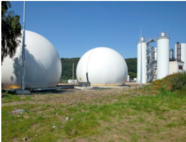
Die runden Behälter speichern das Biogas aus der Papierabwasserreinigung.
