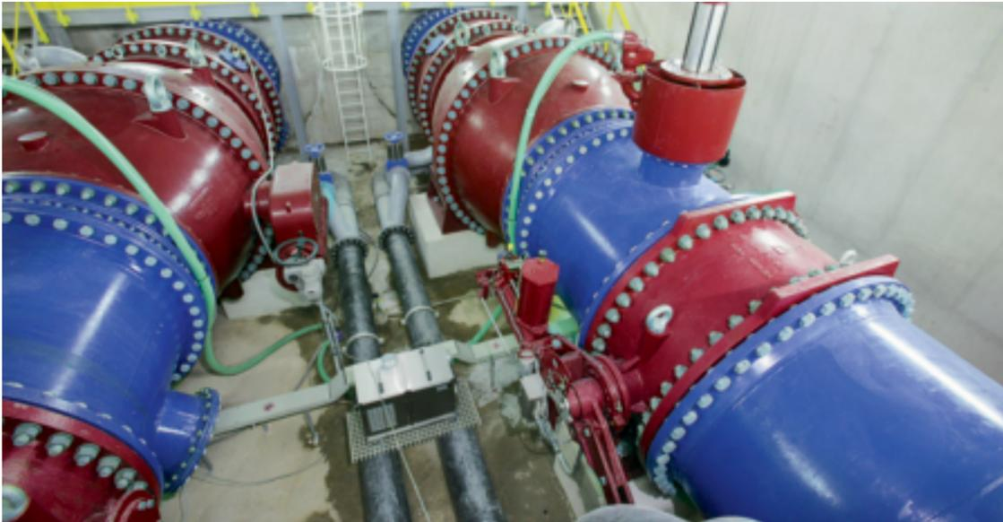
Der Betriebsauslass am Kraghammer Sattel ist eine der Wasserabgabemöglichkeiten der Biggetalsperre.
