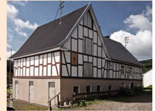
Im Kreis Olpe konnte auch diese schöne Hofanlage in Kirchhundem mithilfe der NRW-Stiftung unterstützt werden.
