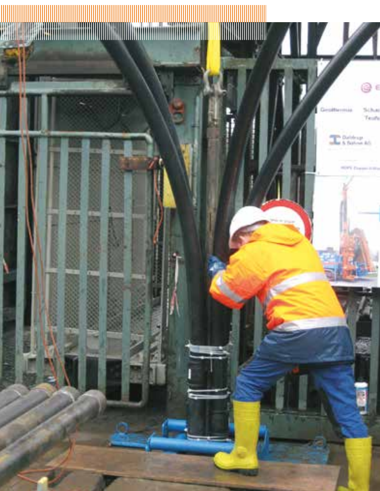
Einbringen der Schachtsonde zur Grubenwassernutzung am Schacht Auguste Victoria
