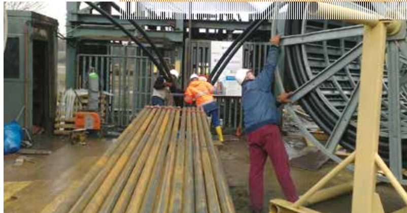
Einbringen der Schachtsonde zur Grubenwassernutzung am Schacht Auguste Victoria
