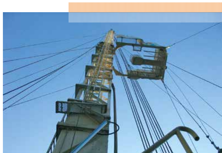
Tiefenbohrung in Aachen
