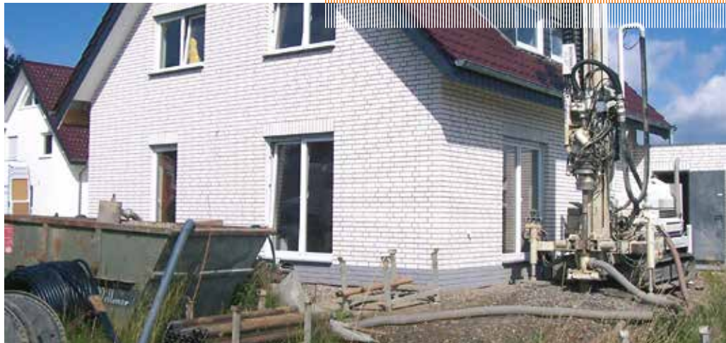
Erdbohrung für ein Einfamilienhaus
