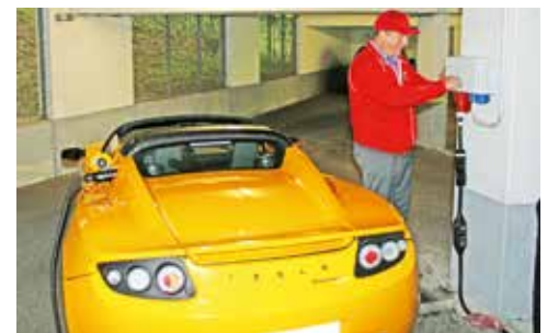
Im Rahmen der Einweihung der Köber Rheinland StBG mbH nutzt Johann Köber den Komfort der neuen Ladestation in der Hellersbergstraße 14
