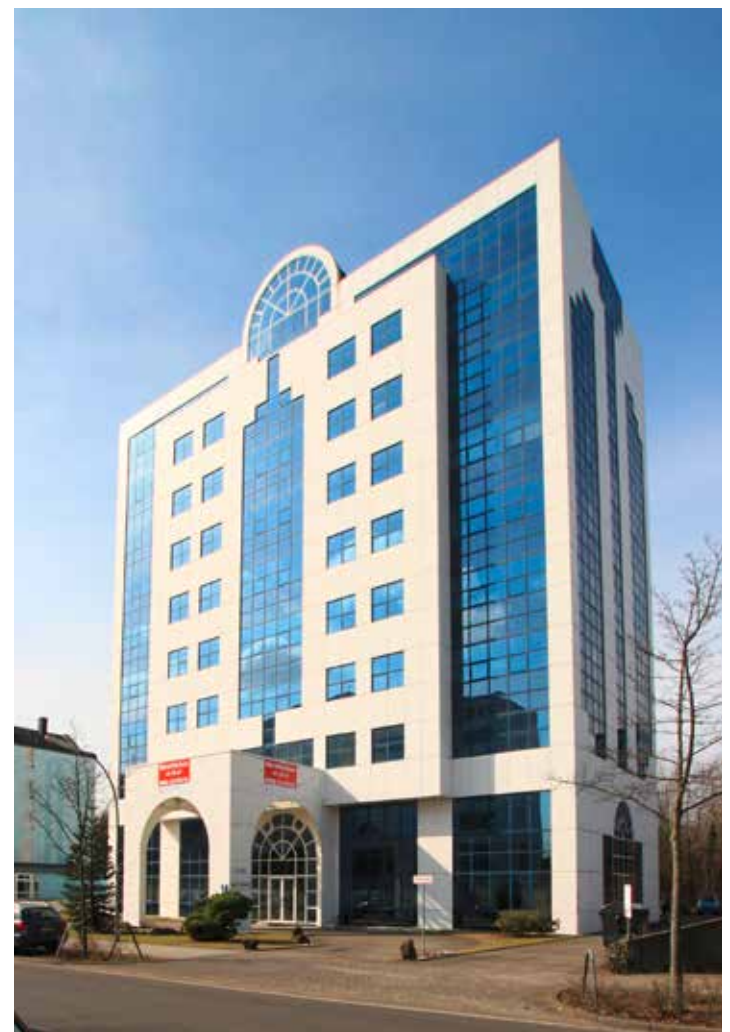
Erinnert an Gebäude in Dubai, die optisch und technisch ausgereifte Immobilie auf der Hellersbergstraße
