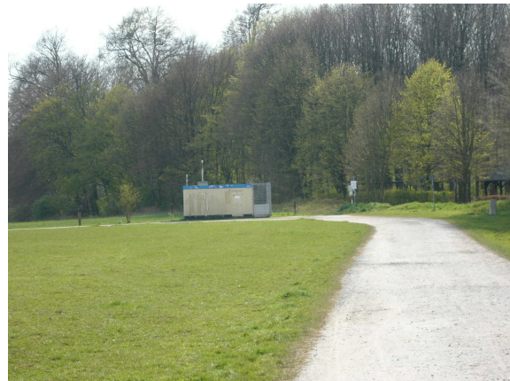
Ansicht Richtung Südwesten
