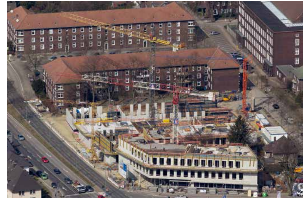
Oben / unten: Baustelle Bottrop im Mai 2013.
