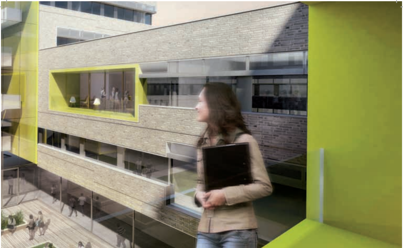
IM JULI 2012 GEHT'S LOS MIT DEM SPATENSTICH. IM HERBST FOLGT DANN FÜR DEN NEUEN HRW CAMPUS AN DER DUISBURGER STRASSE DIE GRUNDSTEINLEGUNG.
