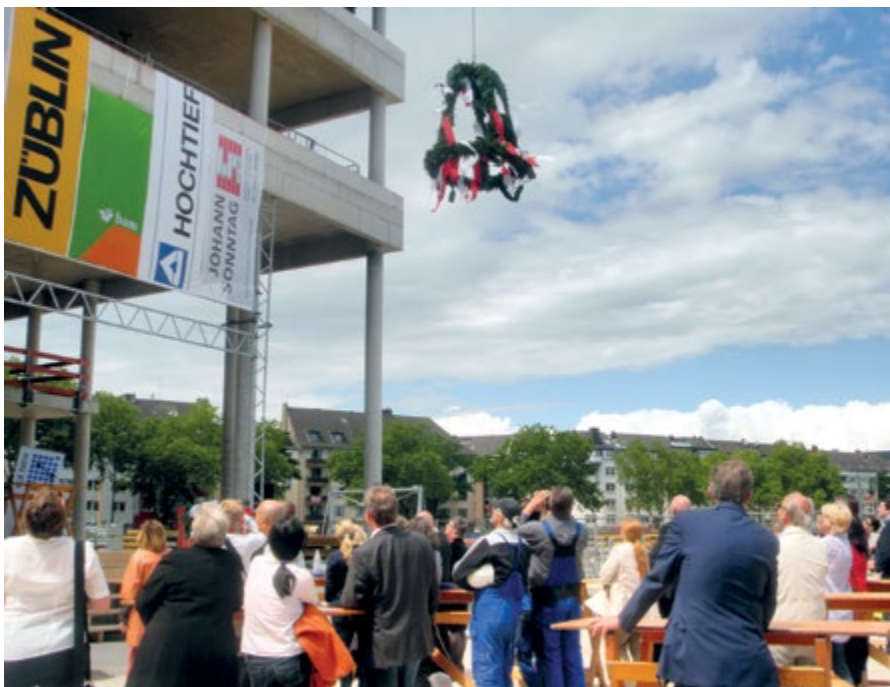
Der Richtkranz konnte bei strahlendem Sonnenschein gehisst werden.
