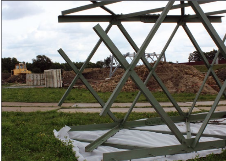
Abb. 7: Zuwegungen sowie Bau- und Baustelleneinrichtungsflächen können Biotope, Böden und Tierwanderwege beeinträchtigen.
