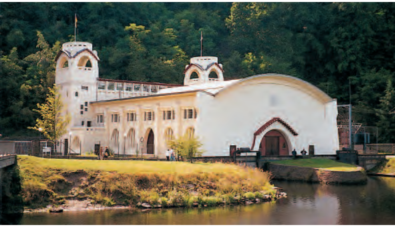
Das Jugendstil-Kraftwerk Heimbach wurde 1905 als größtes Wasserkraftwerk Europas in Betrieb genommen.
