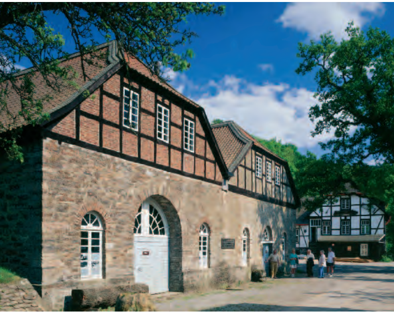
Die Luisenhütte in Balve-Wocklum ist die älteste bekannte Holzkohlenhochofenanlage Deutschlands mit vollständig erhaltener Inneneinrichtung.
