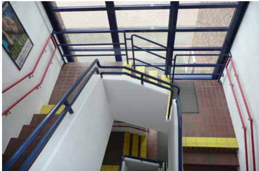
Abb. 16: Treppe mit auffälliger Stufenkennzeichnung und beidseitigem Handlauf
