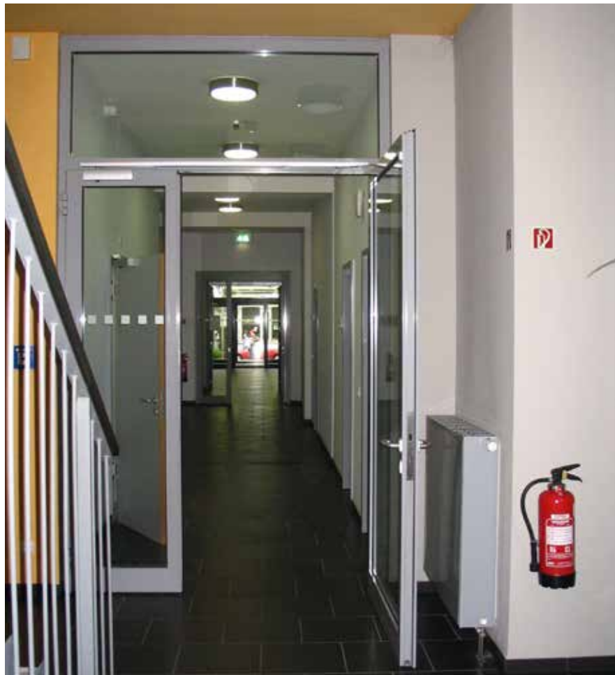
Abb. 11: Rauchmeldergesteuerte Feststellanlage
