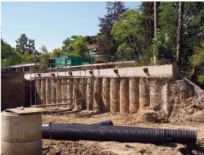
Bohrpfahlwand (Quelle: BRW)
