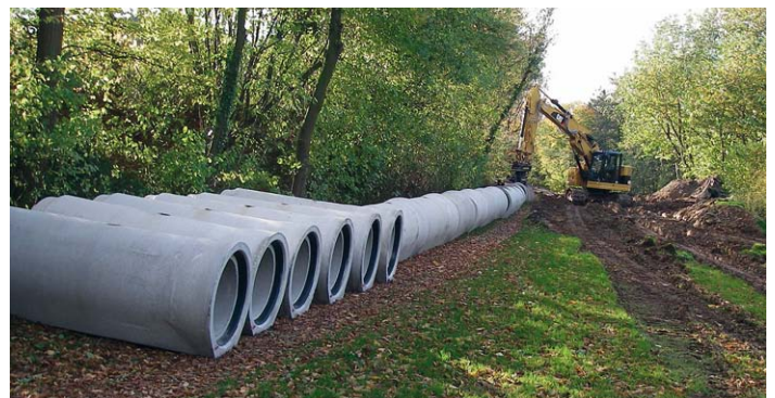
Rohr der Zulaufkanäle vor dem Einbau (Quelle: BRW)
