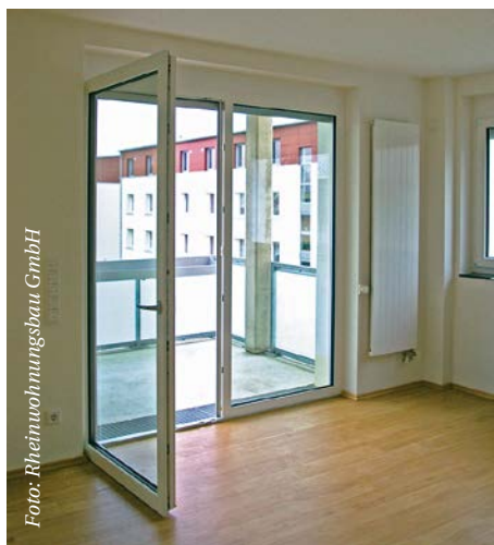
Ausgeführt nach DIN 18040-2
