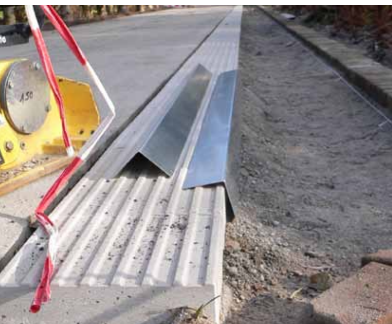
Abbildung 81: Einbau des Leitstreifens aus Rippenplatten im Grugapark.
