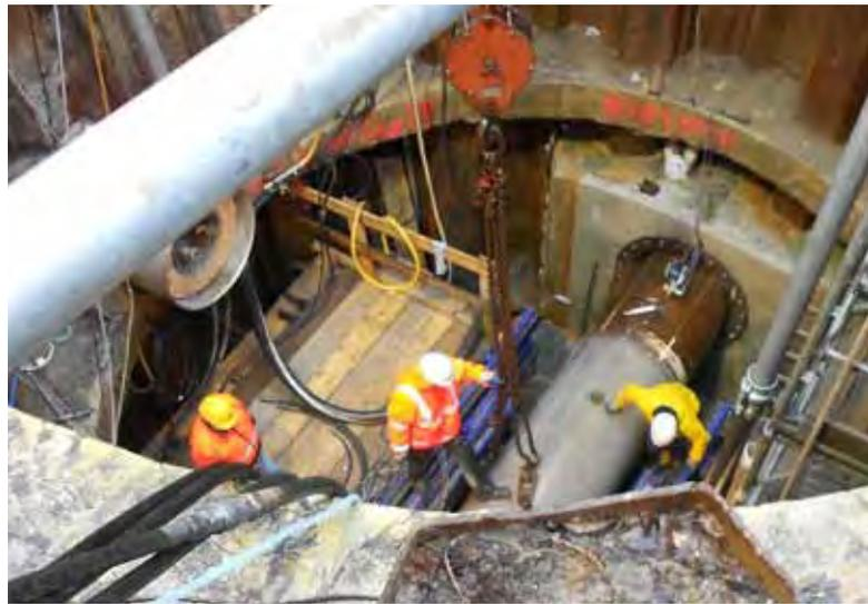
Abbildung 17: Pressgrube für den Abwasserkanal, Januar 2013
