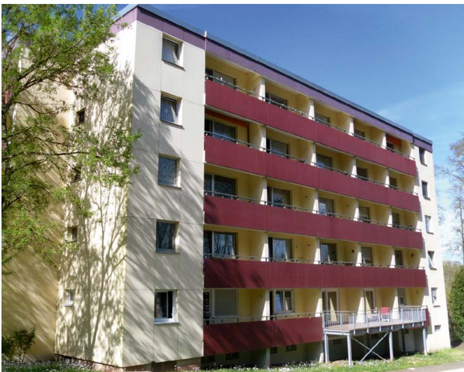
Das 1973 erbaute Objekt erfuhr eine umfangreiche Modernisierung.
