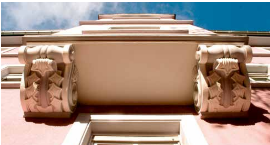
Vereinbarkeit von Funktionalität und denkmalgeschützter historischer Bausubstanz
