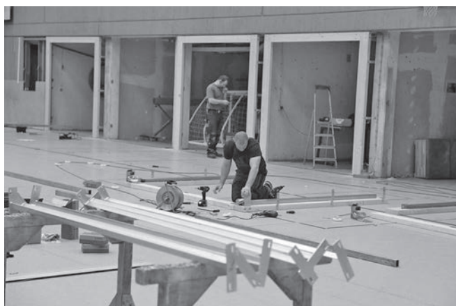
In der Sporthalle Horkesgath wurden Arbeiten unter anderem an den Geräteraumtoren durchgeführt.
