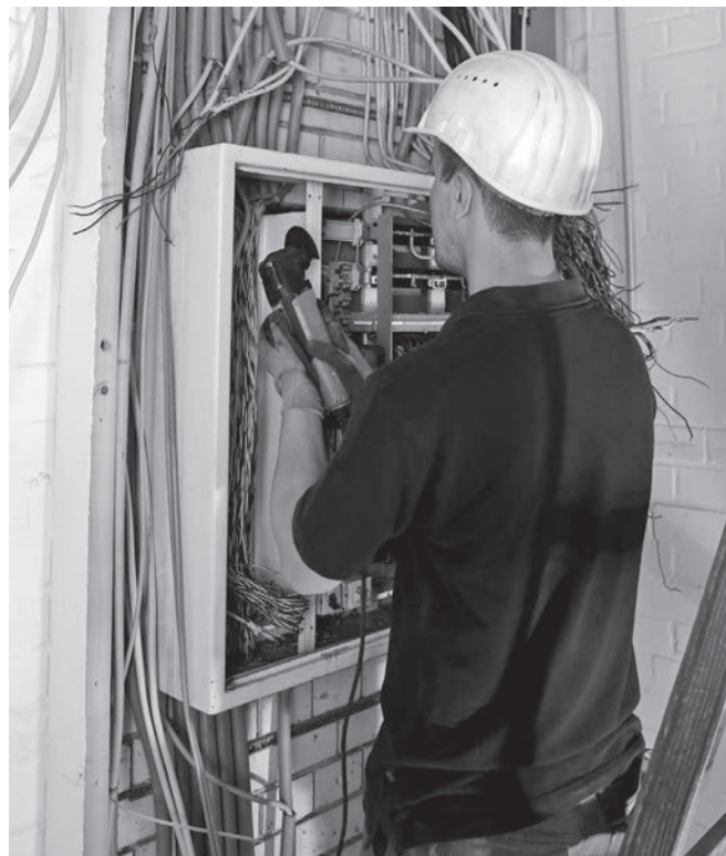
Während der Sommerferien werden in Krefelder Schulen Sanierungsarbeiten für rund 800.000 Euro durchgeführt.
