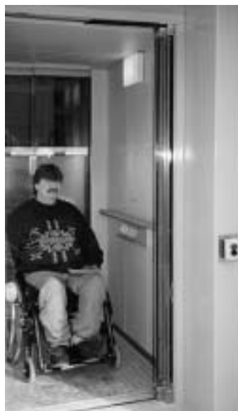
Im Bild: Beispiel einer barrierefreien Aufzugskabine mit waagrechttem Tableau, Spiegel etc. Quelle: USTO-Aufzüge
