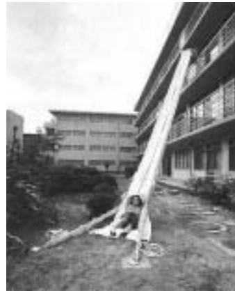
Diese Rettungsruutschen, nutzbar bis zum 12. bis 14. O.G., in senkrechter oder schräger Anordnung, sind die zur Zeit möglichen, für alle anwendbaren Evakuierungswege. Im Schlauch erfolgt eine zwingende Fallbremsung und verhindert ein Aufeinanderstoßen.
