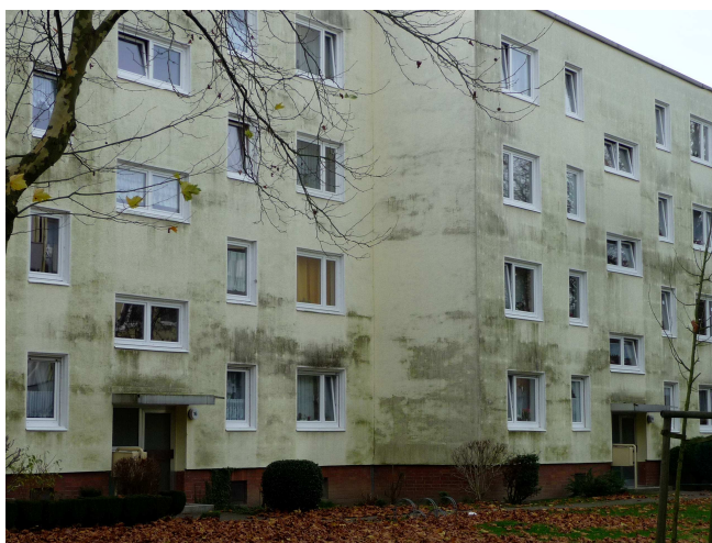
Ältere Wärmedämmung mit Algenbildung
