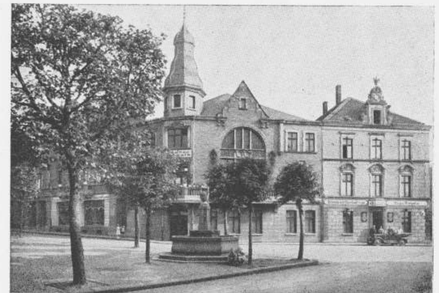
Saalbau Riegels, E.-Kupferdreh , Am Markt (3 Min. von der Anlegestelle und dem Bahnhof entfernt)
