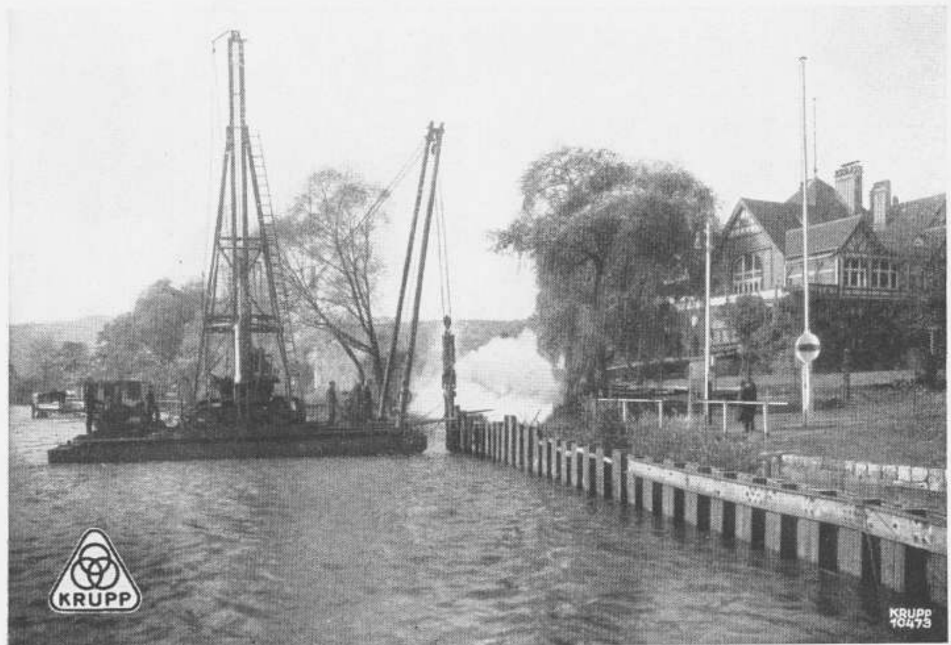
Stahlpundwände Bauart Krupp für die Uferbefestigung am Baldeney-See
